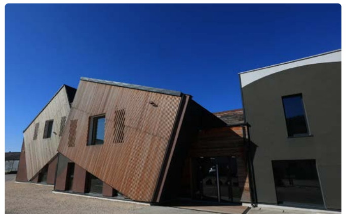
L'atelier numérique, premier bâtiment inauguré
